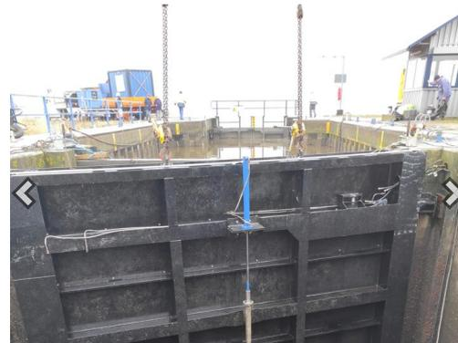
Passt auf den Millimeter genau: Das neue Schleusentor wurde 1:1 nach den Konstruktionszeichnungen des alten Tores nachgebaut.
